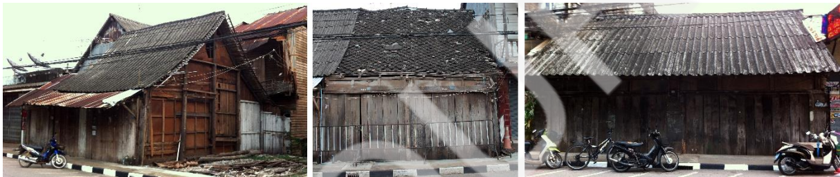
ภาพที่ 6 อาคารพักอาศัยกึ่งพาณิชย์รุ่นเก่าแก่ที่สุดที่หลงเหลืออยู่ในชุมชนเมืองชลบุรี มีลักษณะเป็นห้องแถวติดดินหลังคาทรงจีน ที่มา : การสำรวจและเก็บข้อมูลภาคสนาม
