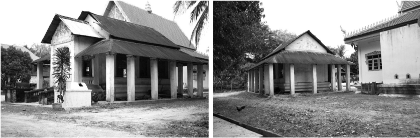
รูปที่ 4 (ซ้าย) สภาพปัจจุบันของลิม จะเห็นว่าหลังคาส่วนใหญ่จะยังเป็นวัสดุเดิม แต่ได้เสื่อมโทรมไปตามกาลเวลา (ขวา) ด้านหลังของลิม ซึ่งมีการก่อสร้างศาลาอเนกประสงค์ขึ้นในบริเวณที่แต่เดิมเป็นหอแจกไม้ โดยสร้างให้มีขนาดเท่าอาคารเดิมเพียงแต่ไม่ได้ยกพื้นสูง
