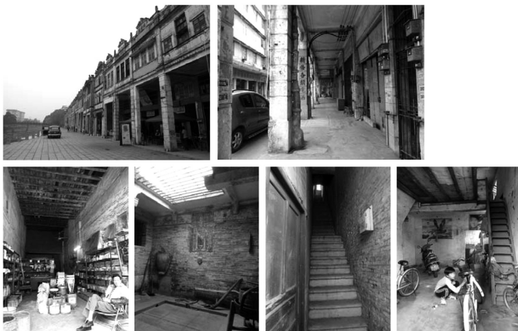
ภาพที่ 2 (บนซ้ายและขวา) ฉีโหลวที่สร้างขึ้นในต้นศตวรรษที่ 20 ในพื้นที่ตำบลซือชาน เมืองจ้านเจียงของกวางตุ้ง ซึ่งเคยเป็นชุมชนการค้าที่มีหัวเฉียวอาศัยอยู่มากแห่งหนึ่ง (广东省湛江市赤坎镇) (ล่างจากซ้ายไปขวา) แสดงโครงสร้างพื้นชั้นสองที่เป็นไม้ใช้ร่วมกับโครงสร้างผนังก่ออิฐรับน้ำหนัก / แสดงแนวคิดการใช้ช่องเปิดขนาดเล็ก (atrium) บนลานภายในบ้านที่หมู่บ้านไคผิง (广东开平市自力村) ซึ่งถูกนำไปใช้กับฉีโหลวเช่นกัน/ บ้านใดของฉีโหลวรูปแบบต่างๆ ซึ่งจะเห็นการทำช่องเปิด เพื่อเพิ่มแสงสว่างและการระบายอากาศให้บ้านได้ที่ยาวและแคบ
