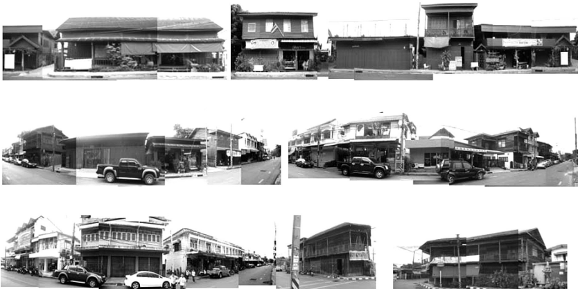
รูปที่ 7 อาคารตึกแถวพาณิชย์ ห้องแถวไม้ อาคารพักอาศัยพื้นถิ่น บริเวณถนนโฆมาสุข ที่มา : จากการสำรวจ
