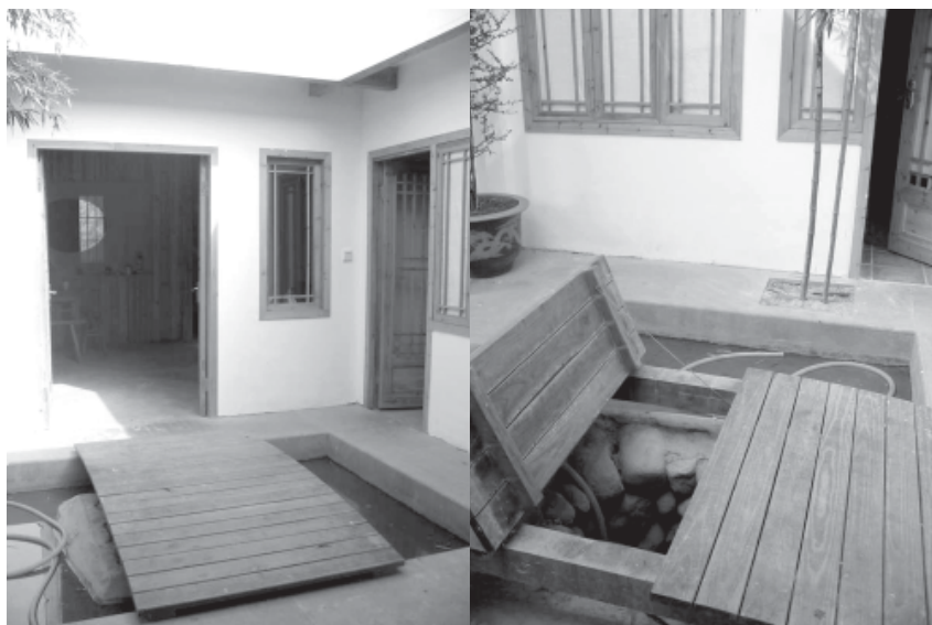
ภาพที่ 15,16 บ่อน้ำกลางลานบ้าน ที่ปิดไว้ด้วยสะพานทางเดิน
