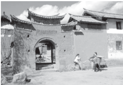
ภาพที่ 5 หมู่บ้านชาซี มณฑลยูนนาน ซึ่ง ครั้งหนึ่งเป็นเมืองการค้าในเส้นทางสายไหม อาคารบ้านเรือนในหมู่บ้านใช้วัสดุหลักเป็นดิน ร่วมกับโครงสร้างไม้
