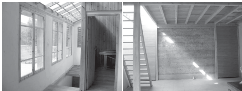
ภาพที่ 17,18 หน้าต่างและหลังคากระฉก สามารถนำแสงสว่างมาสู่ชั้นล่าง ได้เป็นอย่างดี โดยเฉพาะในช่วงเช้า
