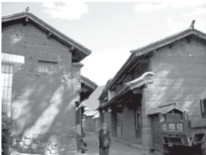
ภาพที่ 6 ดินดินที่เป็นอาคารพาณิชย์ที่หมู่บ้าน ชาซี ทำจากผนังดินอัด (rammed earth) ผสม กับการใช้อิฐดินดิบ (Adobe) รับหลังคา โดยมี ส่วนฐานเป็นอิฐเผา ส่วนชายคายื่นยาวกันฝน ต่างจากบ้านดินทางภาคเหนือ ซึ่งมีชายคาที่ สั้นมาก จะพบว่าพื้นที่แถบนี้เป็นที่ราบสูง ซึ่ง ดินเป็นดินแดง มีคุณภาพดี จึงให้ความคงทน มากกว่าต่างจากพื้นที่ทางใต้แถบอื่นซึ่งไม่ค่อย ใช้ดินในการก่อสร้างมากนัก เนื่องจากสภาพ อากาศที่ร้อนชื้น ฝนตกชุก
