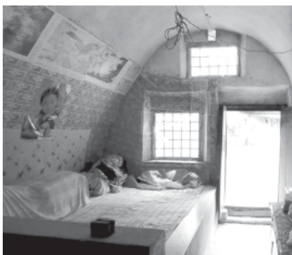
ภาพที่ 2 ภายในของบ้านถ้ำที่เตี้ยมั่งกว้างไว้ติดช่องเปิดส่วนหน้า เนื่องจากเป็นบริเวณที่มีการหมุนเวียนของอากาศดีที่สุด
