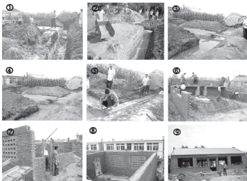
รูปที่ 10 - ขั้นตอนการก่อสร้างบ้านพักอาศัยทั่วไปของหมู่บ้านหลัน
