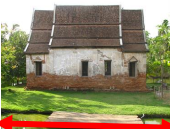
ภาพที่ 3 “ตกท้องช้าง” “หย่อนท้องช้าง” หรือ “ตกท้องสำเภา” “หย่อนท้องสำเภา” อุโบสถวัดหมื่นไวย ที่มา : รุจภา ประวงษ์
