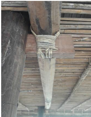
ภาพประกอบ 5 ลักษณะการผูกเรือนของบ้านไทยทรงดำและโครงสร้างไม้ไผ่ที่ทำพื้น ผนังฝาเรือน
