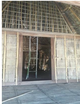
ภาพประกอบ 5 ลักษณะการผูกเรือนของบ้านไทยทรงดำและโครงสร้างไม้ไผ่ที่ทำพื้น ผนังฝาเรือน
