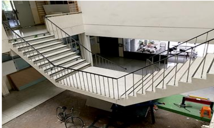
ภาพที่ 4 พื้นที่ชั้นที่ 1 และบันไดทางขึ้นชั้น 2 ของอาคาร
