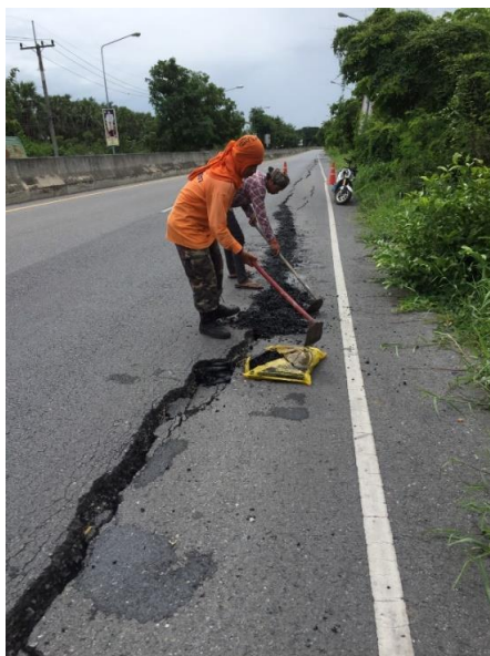
ภาพที่ 4 การซ่อมแซมถนนของ อบต.หนองไม้ซุง
