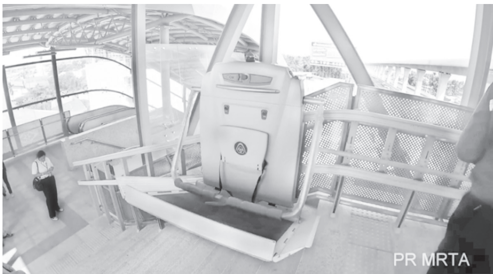
ภาพที่ 5 อุปกรณ์การเคลื่อนย้ายรถนั่งคนพิการที่ติดอยู่ในบริเวณรถไฟฟ้าสายสีม่วง (ที่มา http://www.skyscrapercity.com/showthread.php?t=1138409&page=171 )
