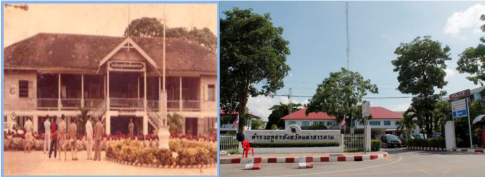
ภาพที่ 2 สถานีตำรวจจังหวัดมหาสารคามในอดีต กับปัจจุบัน
