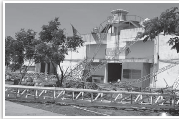
รูปที่ 2 ความเสียหายของคอมไฟส่องสนามศรีนคร จังหวัดศรีสะเกษ ( http://www.thaيلandsusu.com )
