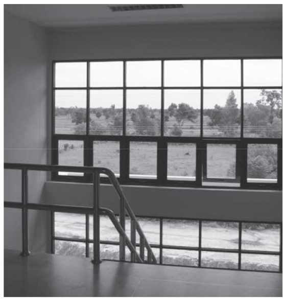
รูปที่ 13 ช่องแสงและช่องลมบริเวณโถงบันไดและการเคลื่อนที่ของลม
