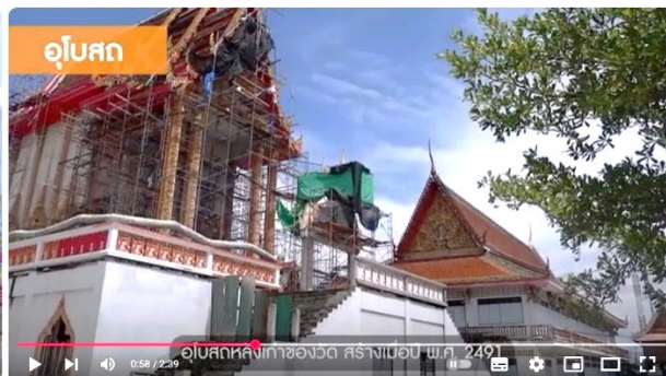
ภาพที่ 2 ฉากอุโบสถที่อยู่ระหว่างการก่อสร้าง
