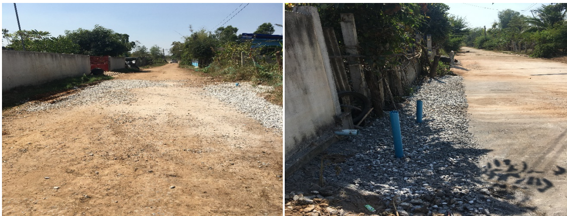
ภาพที่ 10 ภาพพื้นที่หลังการดำเนินการต้นแบบวางระบายน้ำระบบธนาคารน้ำใต้ดิน แบบบ่อพักคู่
