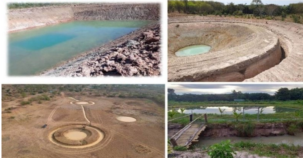
ภาพที่ 5 ธนาครน้ำใต้ดินระบบเปิดแบบสระ
