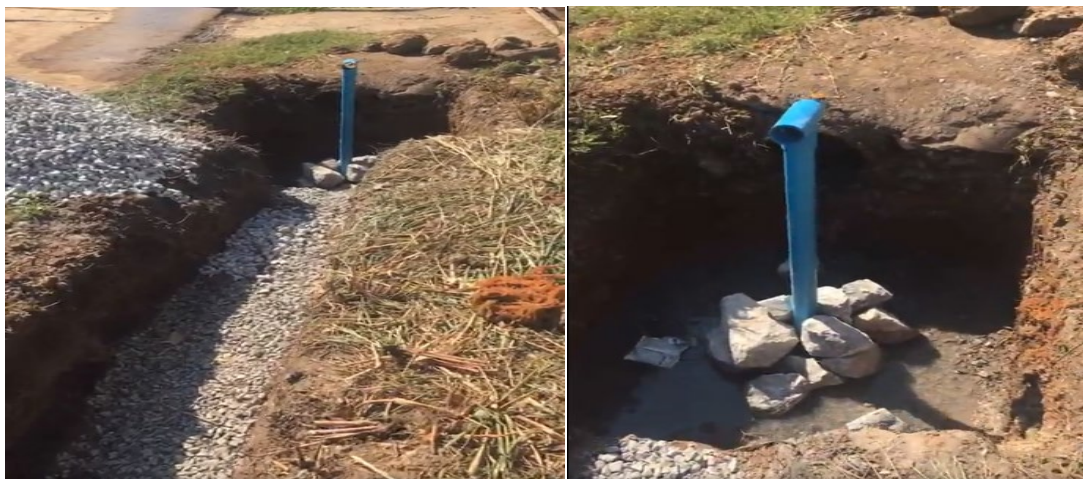
ภาพที่ 8 ลักษณะการเชื่อมต่อระหว่างบ่อพักและรางรับน้ำ
